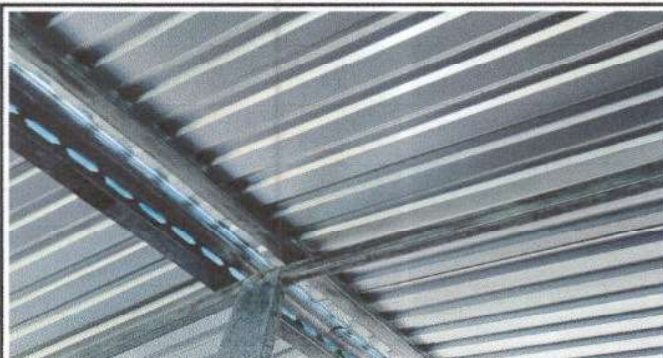
Foto 2: Sustitución de lámina troquelada aluzinc calibre 26. En Módulo I.
