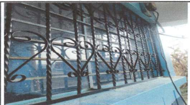
Foto 4: Sustitución de los balcones de las ventanas del establecimiento.
