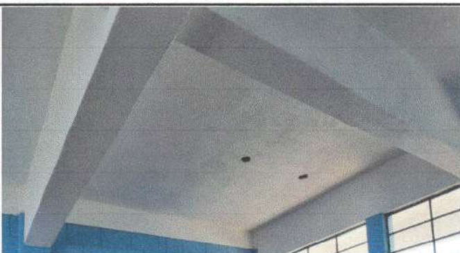
Foto 3: Pintura en muros interiores en Módulo I.
