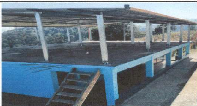
Foto 1: Sustitución de lámina acanalada, por lámina troquelada aluzinc calibre 26 en Módulo I.
